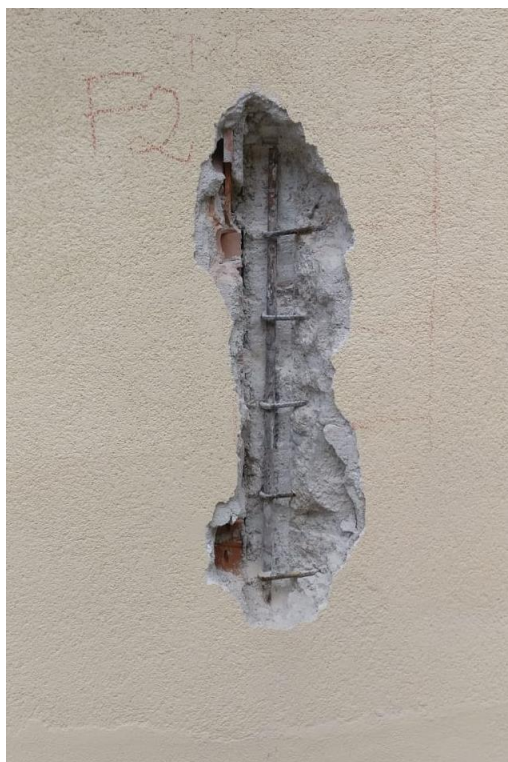
Figura 5.10 - Estrazione barre di Armatura F2
