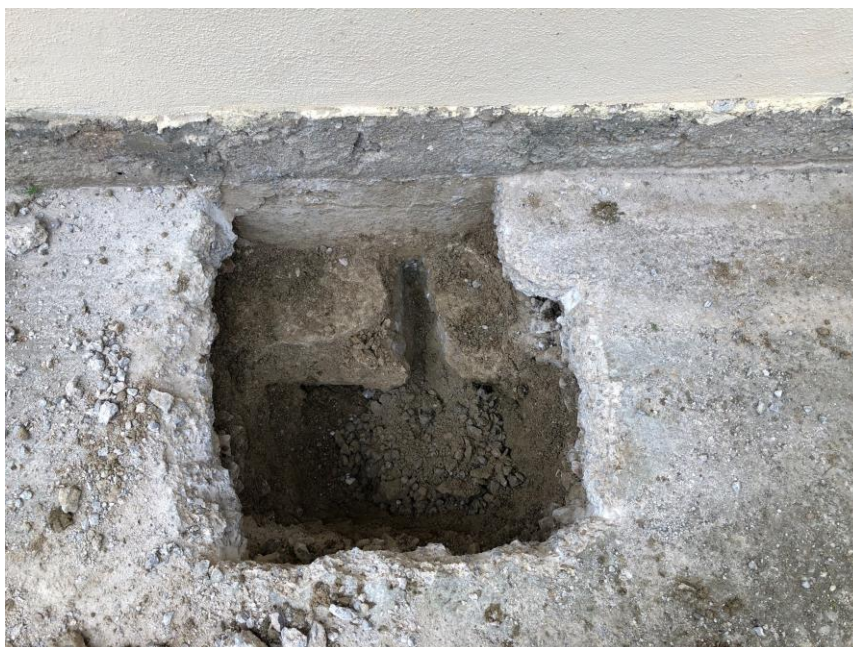
Figura 5.17 – Saggio per le fondazioni
