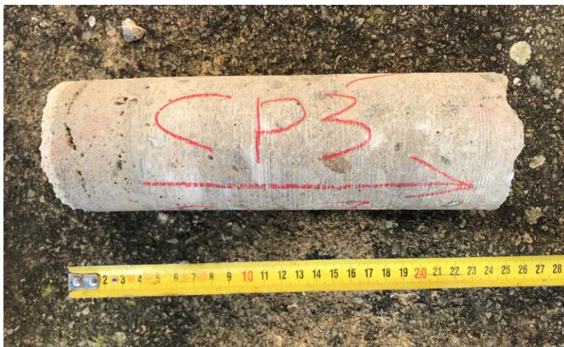
Figura 5.7 – Verifica della profondità di Carbonatazione campione CP3
