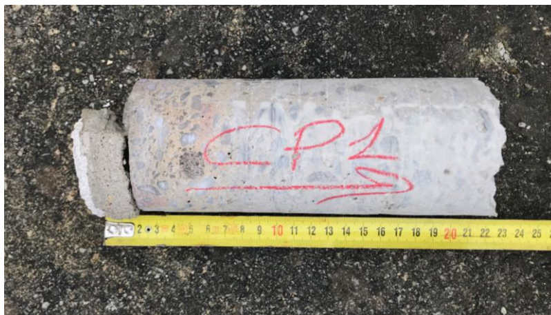
Figura 5.5 – Verifica della profondità di Carbonatazione campione CP1
