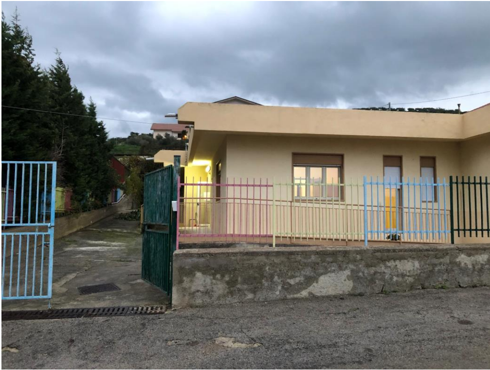
Figura 3.1 – Ingresso area scolastica
