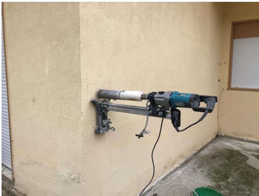
Figura 5.1 - Carotaggio, campione CP3
