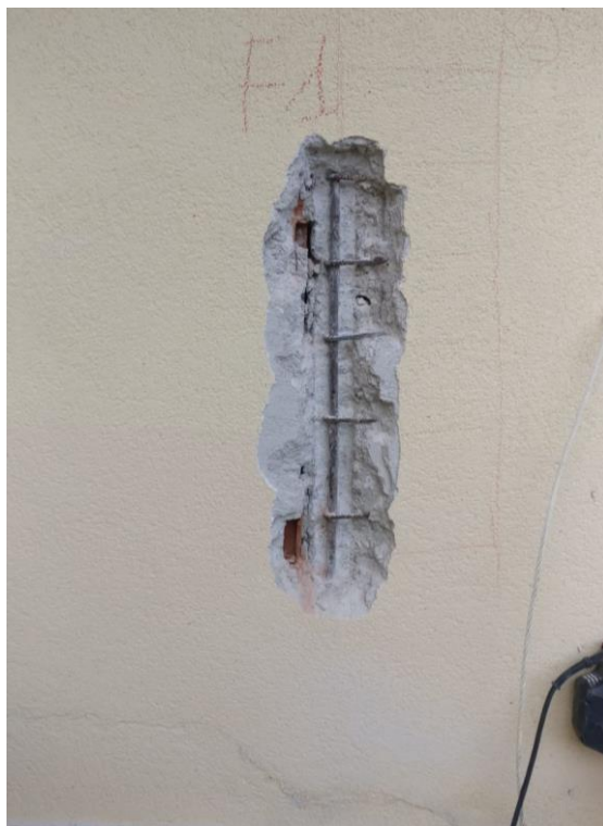
Figura 5.9 – Estrazione barre di Armatura F2
