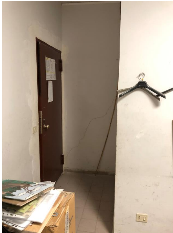
Figura 3.5 – Lesione inclinata a 45° nel disimpegno
