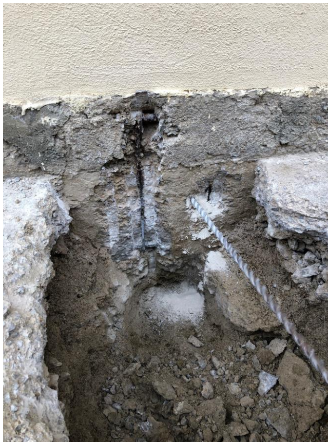
Figura 5.18 – Saggio per le fondazioni
