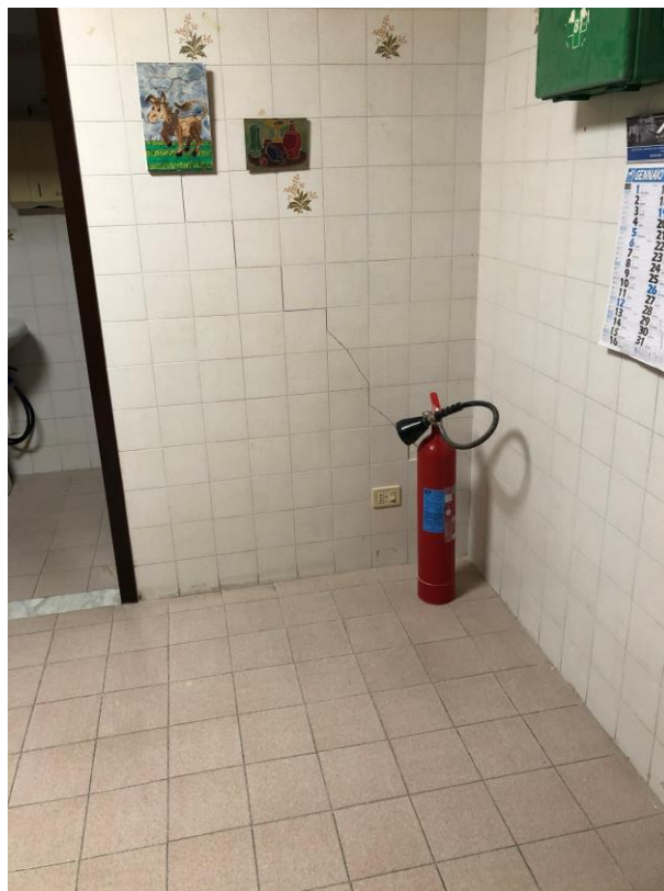
Figura 3.6 – Lesione inclinata a 45° nella sala professori
