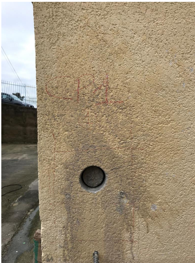
Figura 5.4 – Carotaggio, campione CP1
