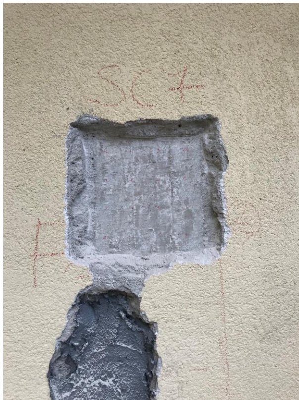
Figura 5.15 - Indagine Sclerometrica, Pilastro SC7
