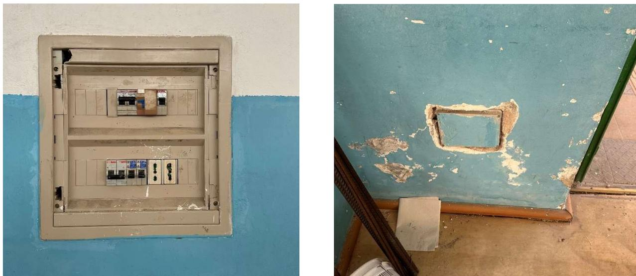
Fig. 5 Degradati impianto elettrico palestra
