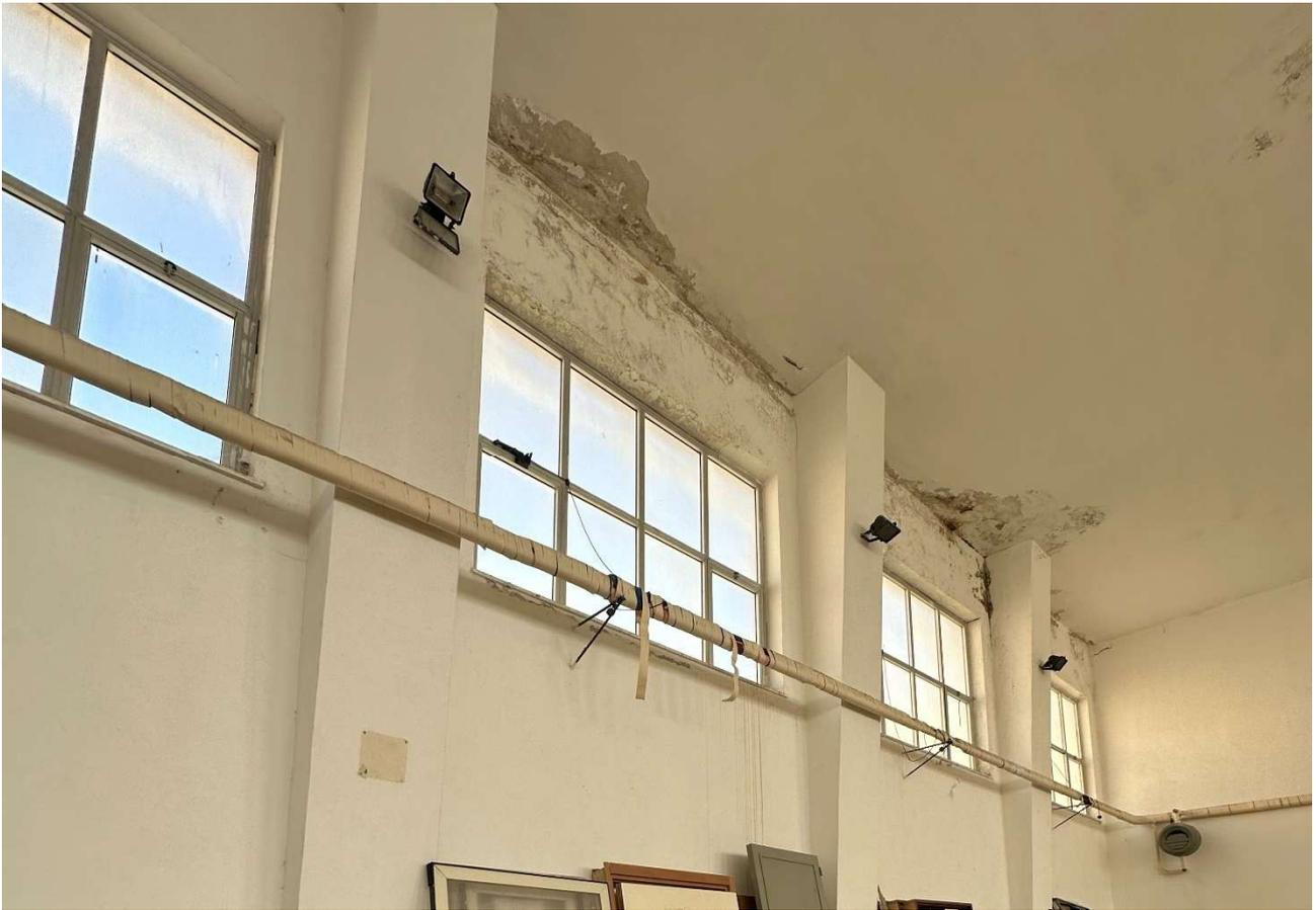
*Fig. 4 infiltrazioni e umidità di risalita*
